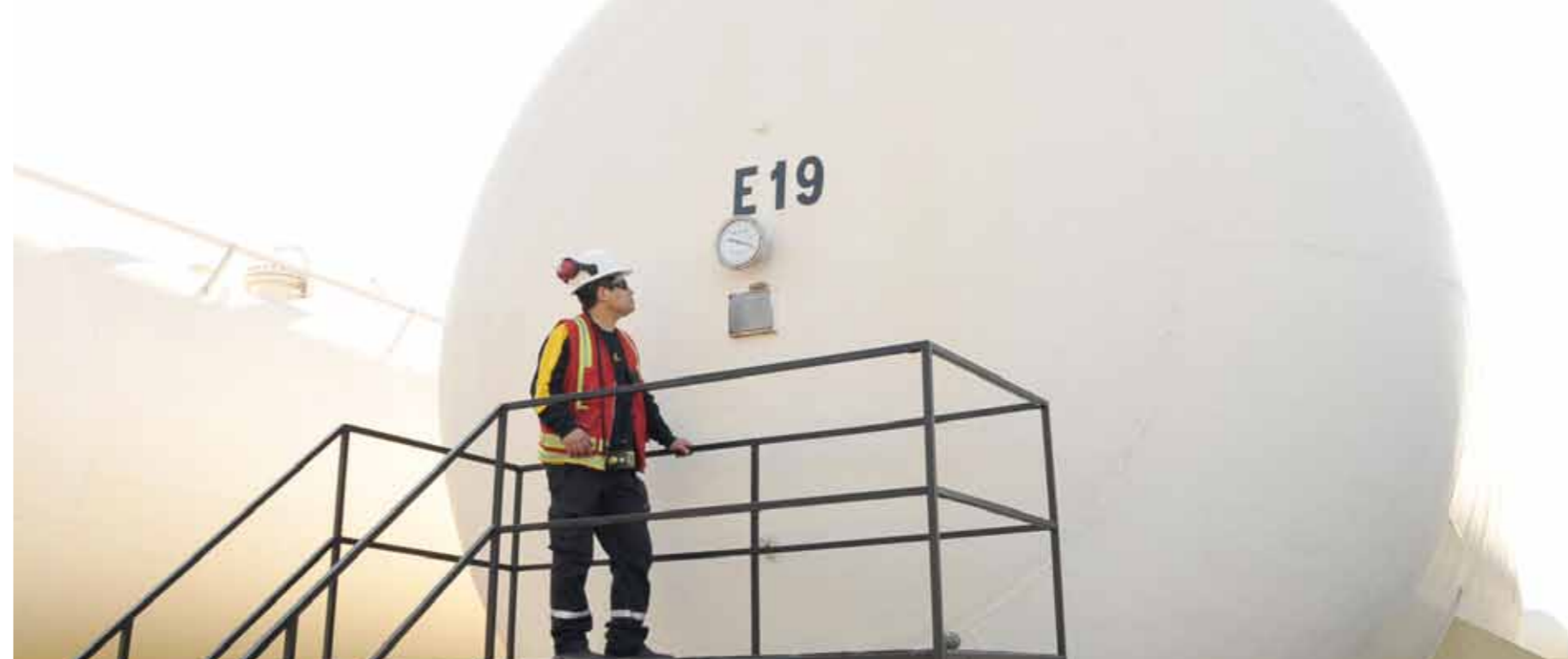
Foto: Estanque de almacenamiento
